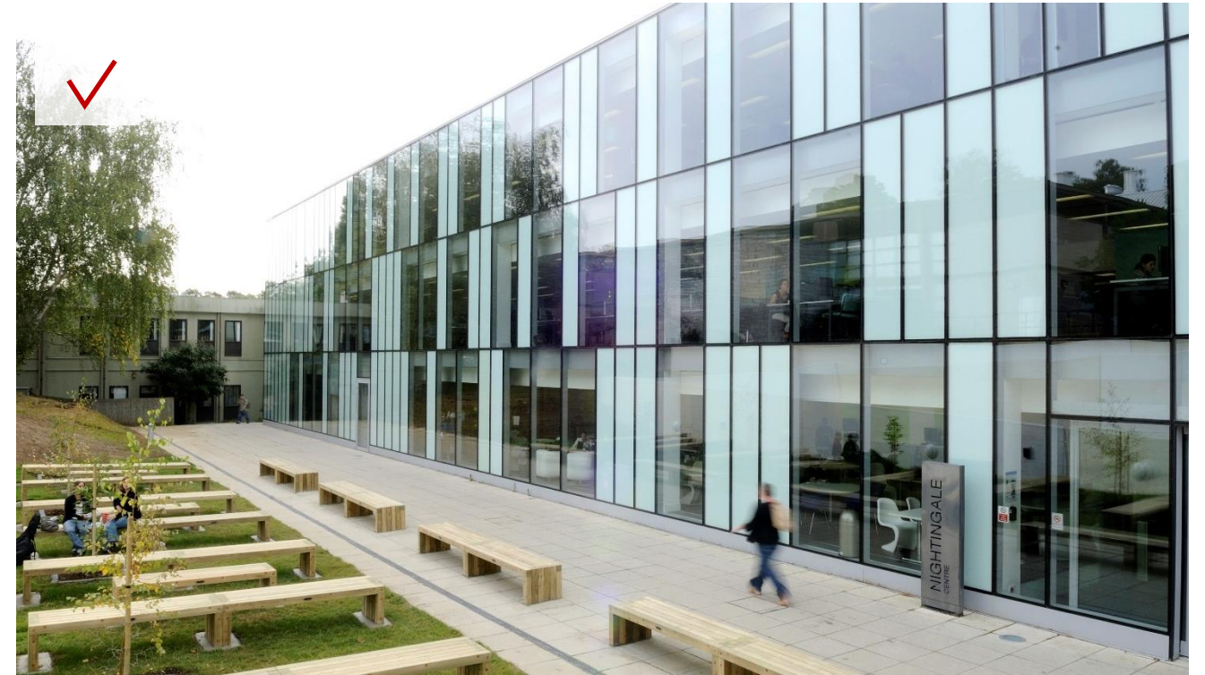
דוגמא: רחבת כניסה המשמשת מרחב ציבורי, שימוש בריווט רחוב לרווחת עוברי האורח
